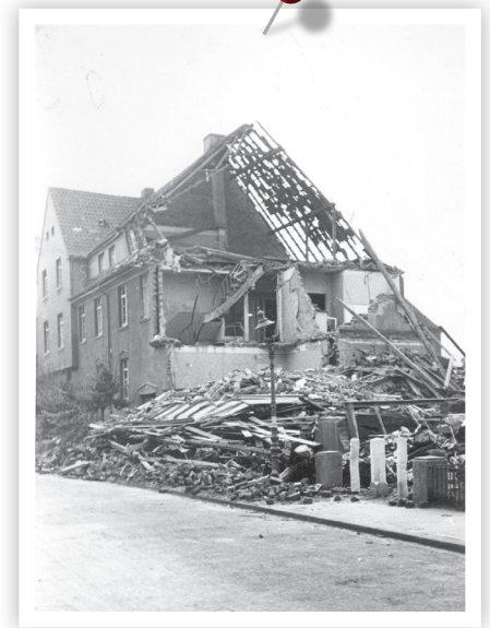
Bombenschäden am Vinzenzweg (Quelle: Stadtarchiv Münster)
