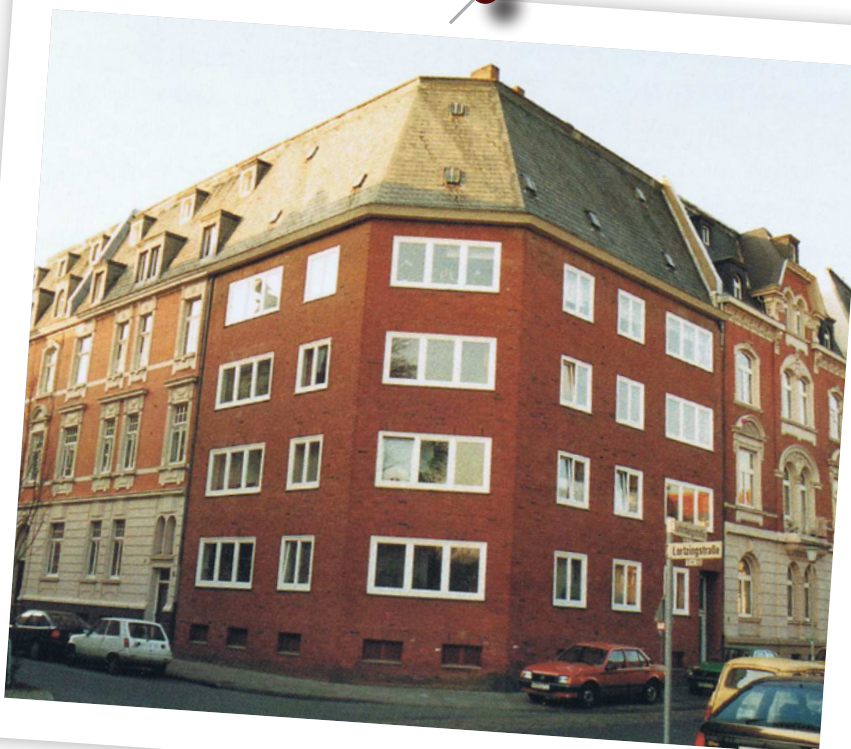
Wiederaufbau an der Gutenbergstraße/ Maybachstraße
