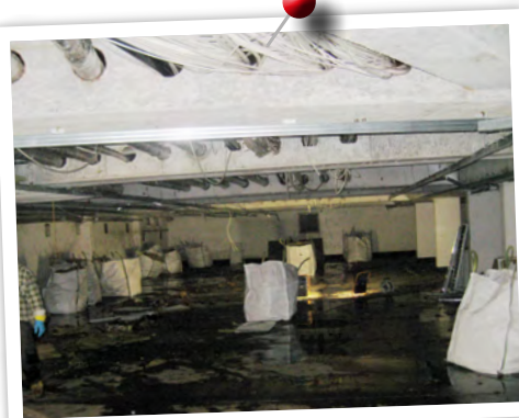
Die zerstörte Kellerdeckenisolierung wurde in Bigbags verpackt und entsorgt
